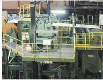
Instalação de reflete
