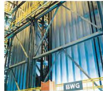
Acumulador de entrada 1 e 2
