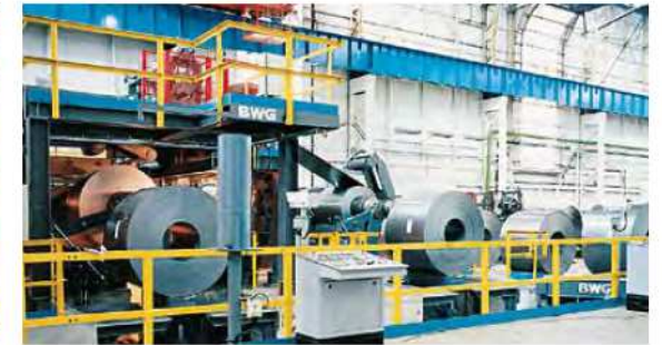
Lado de entrada com desbobinadeira 1 e 2
